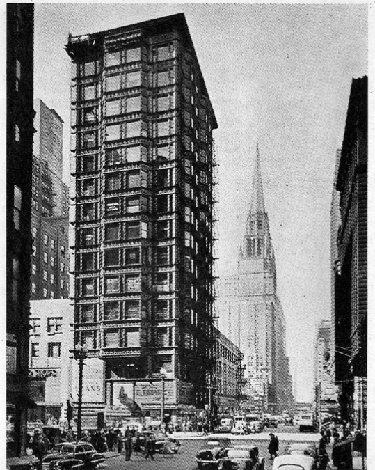
Reliance Building, Σικάγο, 1890. 2 D. H. Burnham, J. W. Root.
