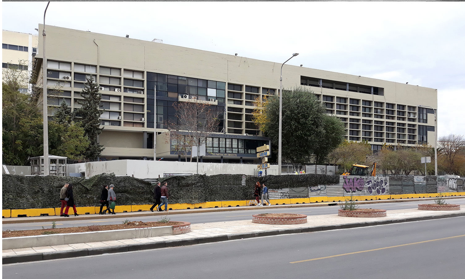
Εικ. 1. Η Θεολογική Σχολή του ΑΠΘ, έργο της δεκαετίας του '60, σχεδιασμένο από τους νεότερους, τότε, αρχιτέκτονες Κώστα Φινέ και Ντίνο Παπαϊωάννου. Άνω: το 1986, αλώβητη ακόμα από παρεμβάσεις. Κάτω: από την ίδια γωνία λήψης τον Νοέμβριο 2018, με το δώμα να έχει «γεμίσει» και την ισόγεια ζώνη να αποκρύπτεται από τις εν είδει οχυρωματικών έργων κατασκευές του μετρό. [φωτ. Π. Εξαρχόπουλος]
