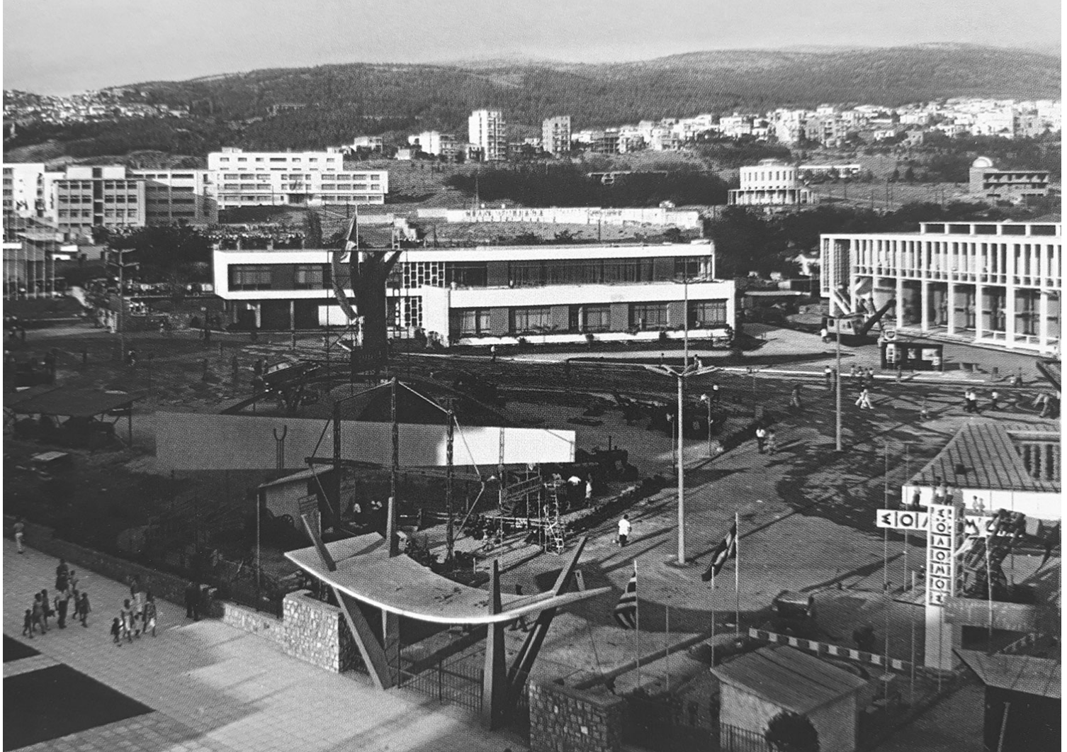
Εικ. 4. Κτήριο Διοίκησης ΔΕΘ, αρχιτέκτονες Π. Βασιλειάδης, Ε. Βουρέκας, Σ. Στάικος, 1959-60. Φωτογραφία εποχής. [Πηγή: Βασίλης Κολώνας, Θεσσαλονίκη 1912-2012. Η αρχιτεκτονική μιας εκατονταετίας , Θεσσαλονίκη 2012]
