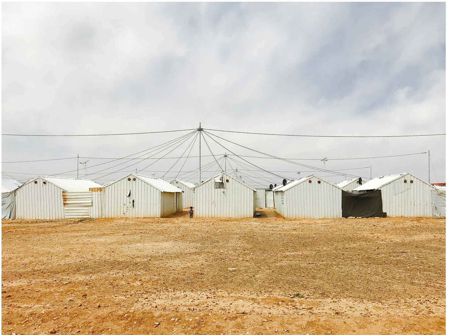
T-Shelter: Το τυποποιημένο ανθρωπιστικό καταφύγιο του καταυλισμού.
