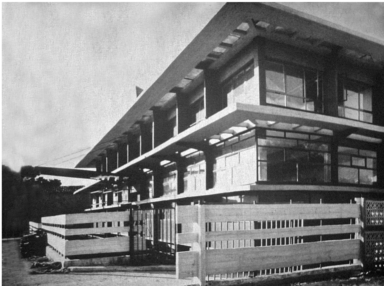
Εικ. 2. Οι εγκαταστάσεις των εκδόσεων ΠΑΙΠΥΡΟΣ (Λεωφ. Κηφισίας, στο ύψος του κόμβου με την Αττική Οδό, Μαρούσι). Τολμηρό έργο του Α. Προβελέγγιου, περίοδος 1957-67. Κατεδαφισμένο.
