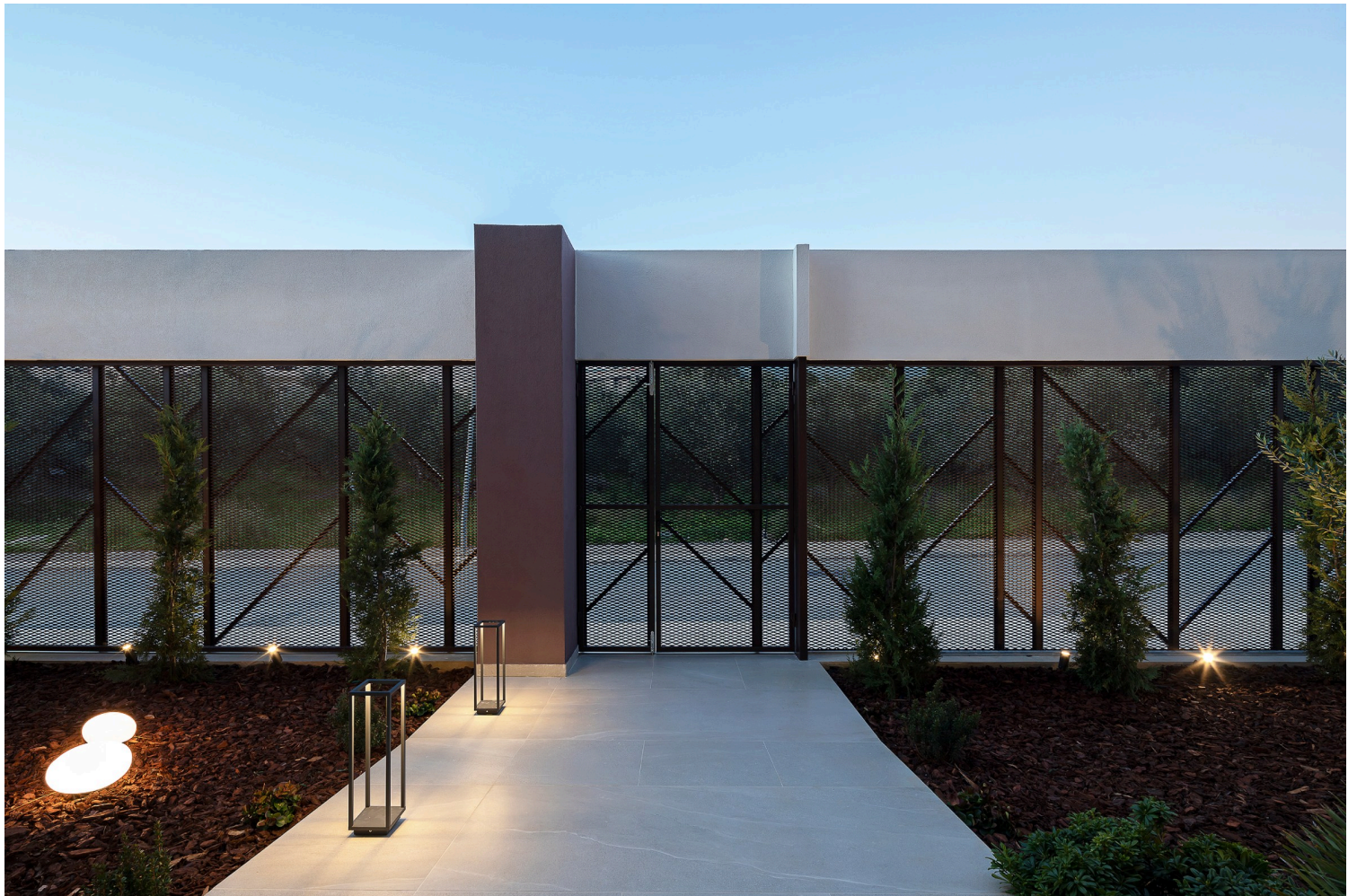
The Nidus / Παθητική κατοικία στην Καλαμάτα, αρχιτεκτονική ομάδα Gonzalez - Malama Architects ( www.gm-a.gr )
