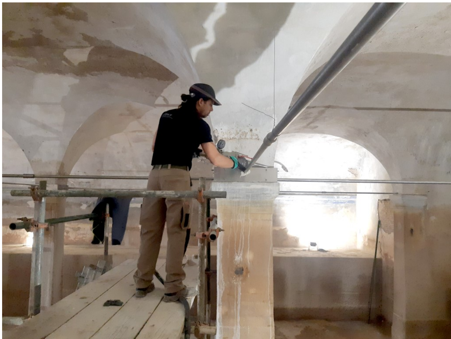
Τοποθέτηση ελκυστήρων για την ενίσχυση με ήπιες επεμβάσεις της Αδριανείου Δεξαμενής.
