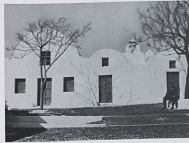
Charakteristische Häuser mit Tonnengewölbe Am Frauenkloster St. Nikolas Herovigli auf Santorin
