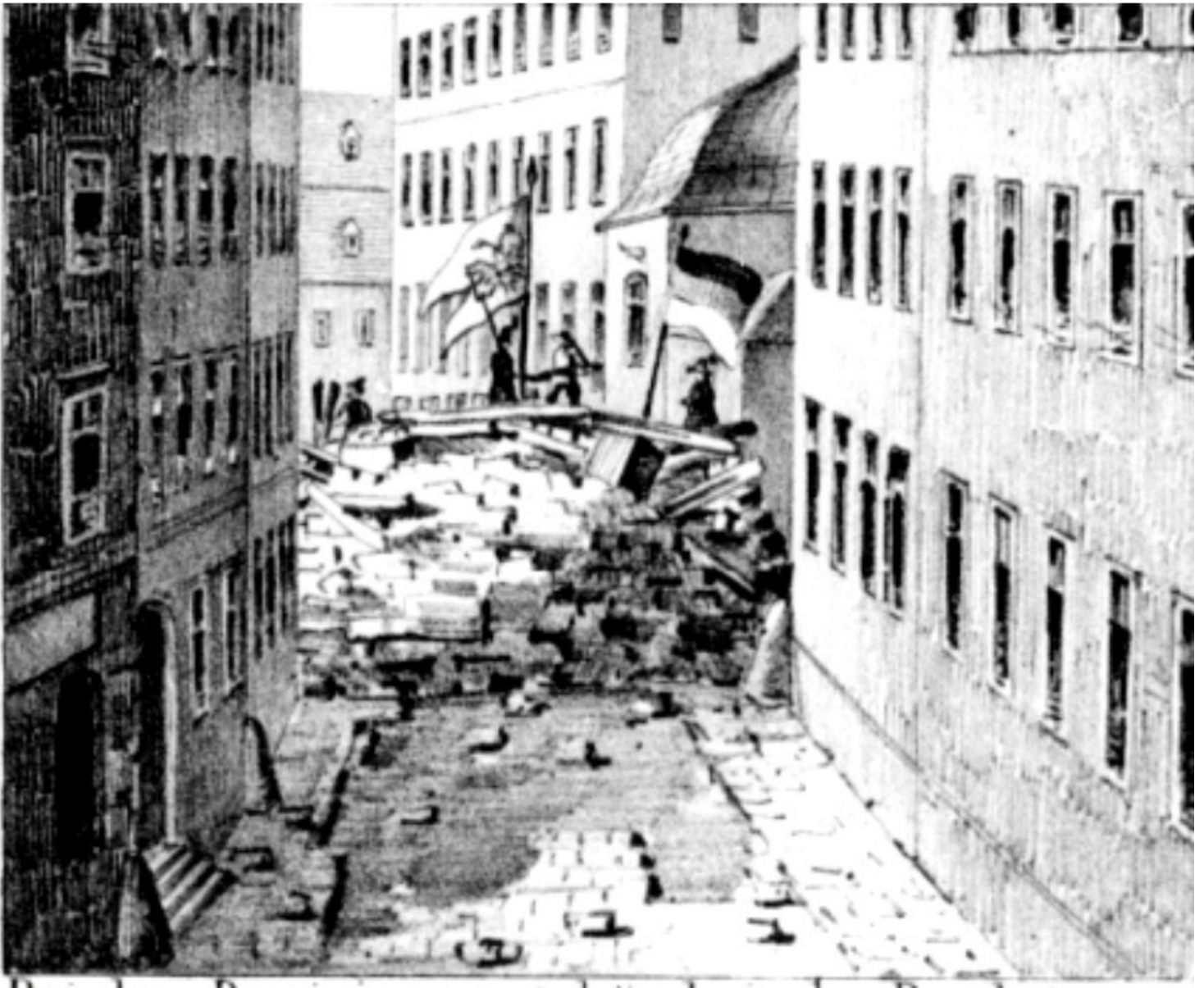
14, 15. Οδοφράγματα στη Βιέννη το 1848 18 . Επάνω αριστερά στη Roteturmstrasse (ο δρόμος που οδηγεί από το κέντρο στον Δούναβη), δεξιά στην Bockgasse στο κτήριο των Δομινικανών.
