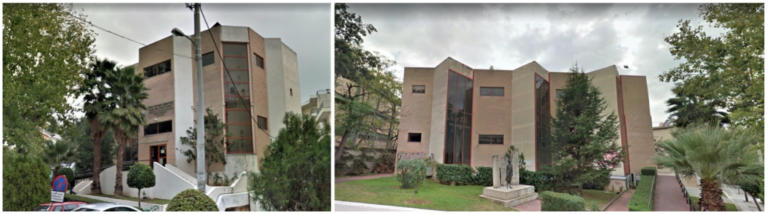
(Εικόνα 4) Το κτίριο που κατασκευάστηκε από τον Δήμο
