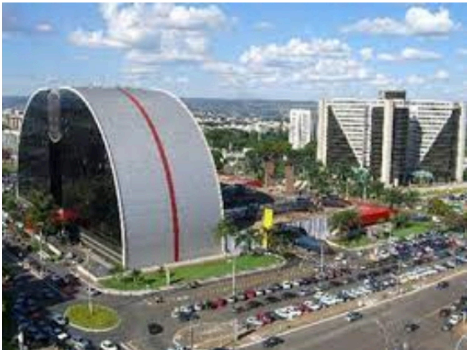
56. και 57. Εικόνες από τη σημερινή Μπραζιλία, με κτήρια της αρχικής «μακέτας» ή μεταγενέστερα... 58
