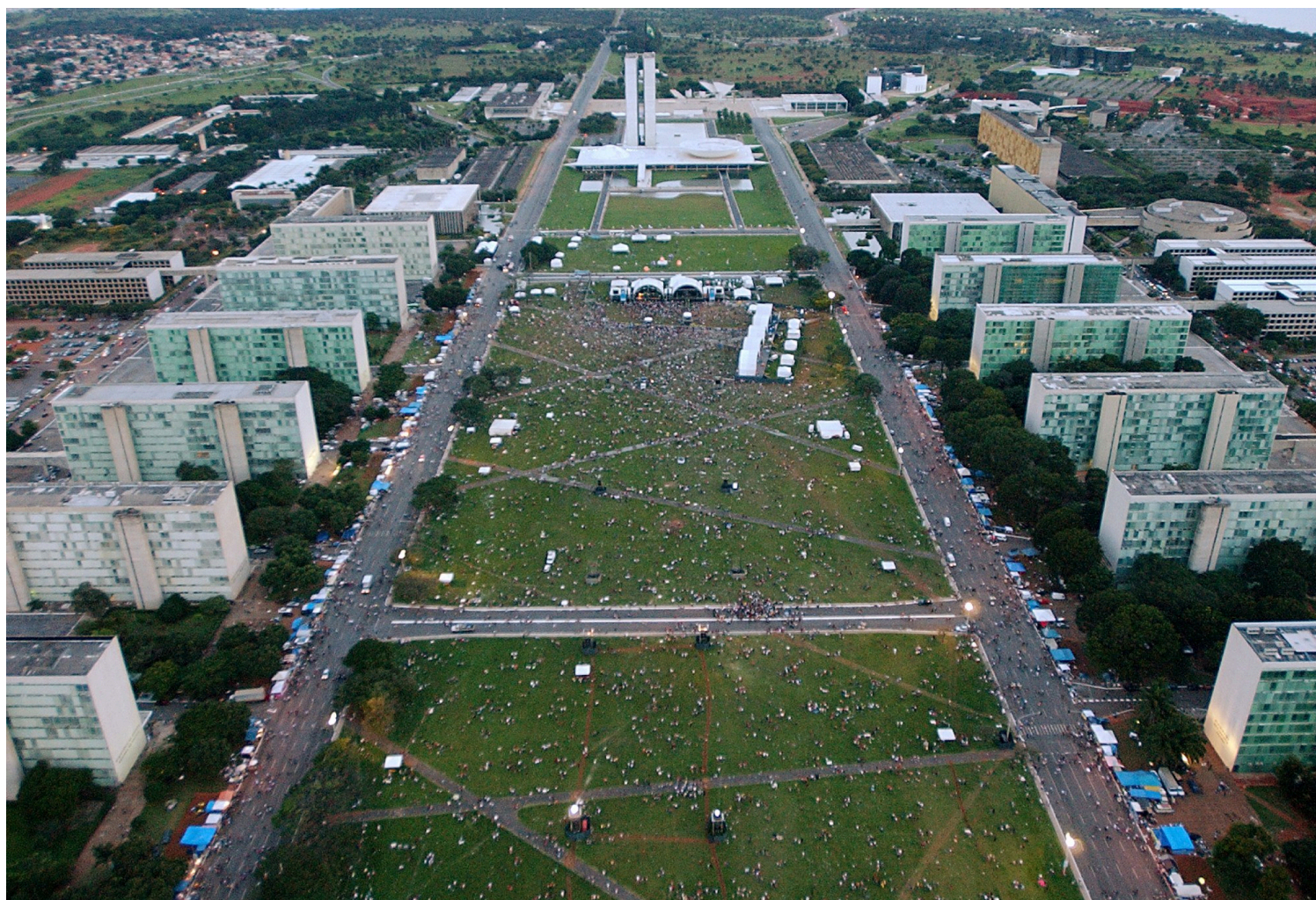
55. Το «κέντρο» της Μπραζιλία, ένας αχανής χώρος με γκαζόν, σε (μνημειακή) διάταξη πολυώροφων απρόσωπων πολυκατοικιών. Αριστερά και δεξιά στις δύο παράλληλες αρτηρίες, μοιάζουν να είναι πρόχειρες κατασκευές μικρομάγαζων, μπαρ, μικροπωλητών κ.α. που δεν χωρούσαν στην μακέτα... 57
