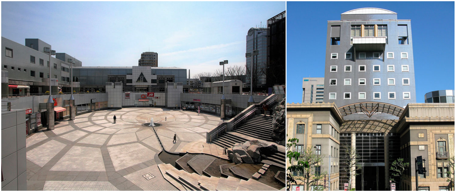
(Αριστερά) Διοικητικό Κέντρο στην Tsukuba (ευρύτερη περιοχή του Τόκιο), 1983, (Δεξιά) Ochanomizu Square Building, Τόκιο, 1987
