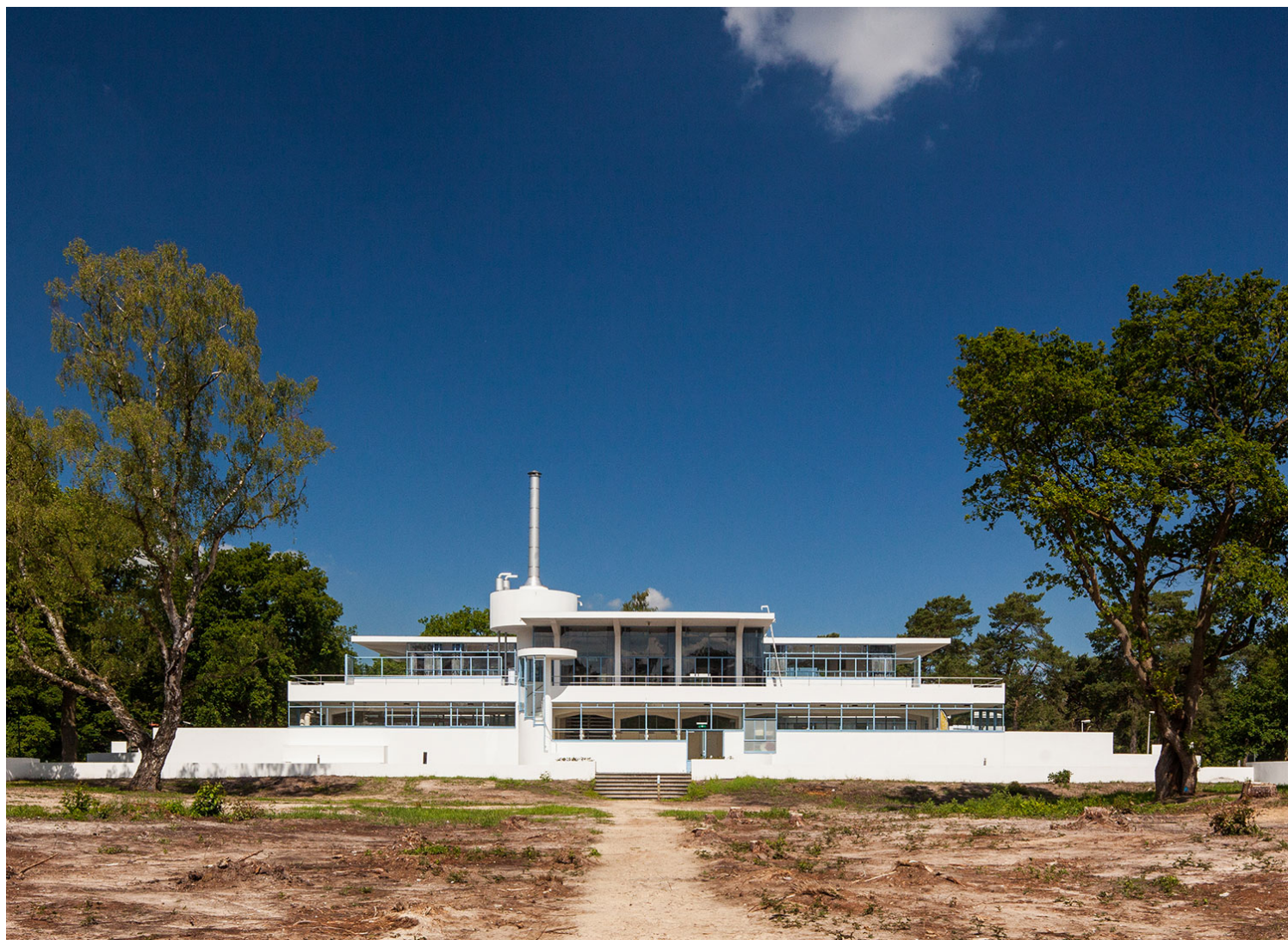
(Εικ. 3) Το αποκατεστημένο πρώην σανατόριο και νυν κέντρο υγείας Zonnestraal στο Hilversum της Ολλανδίας. Πηγή: Wikimedia commons.
