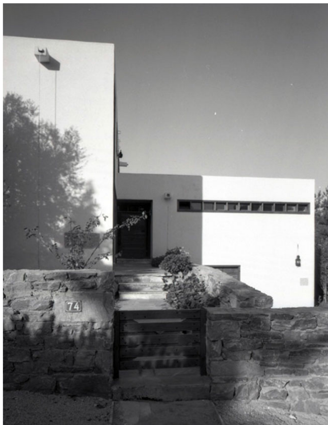
εικ.1. Σ. Καρακώστα, Κατοικία στο Π. Ψυχικό (φωτ. Μ. Σκιαδαρέσης)
