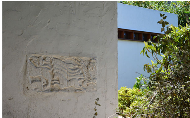
εικ 30. Σ. Καρακώστα. Κατοικία στο Π. Ψυχικό. Λεπτομέρεια πάνω στον εξωτερικό τοίχο (φωτ. Σ. Τσιράκη)
