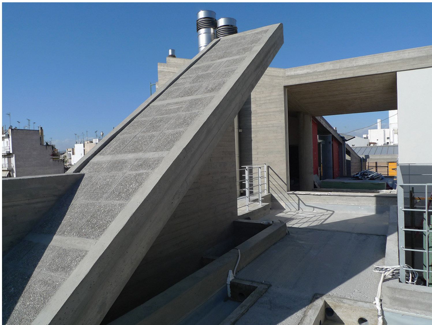
Άνοδος από κατοικία του τελευταίου ορόφου στο φυτεμένο ιδιωτικό δώμα της.
