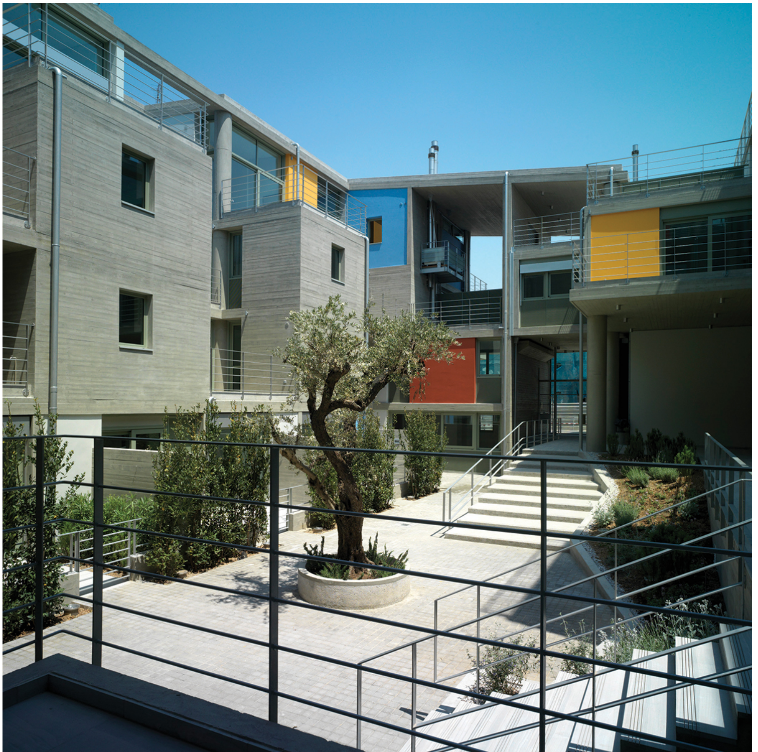
Εσωτερική όψη από το αίθριο
