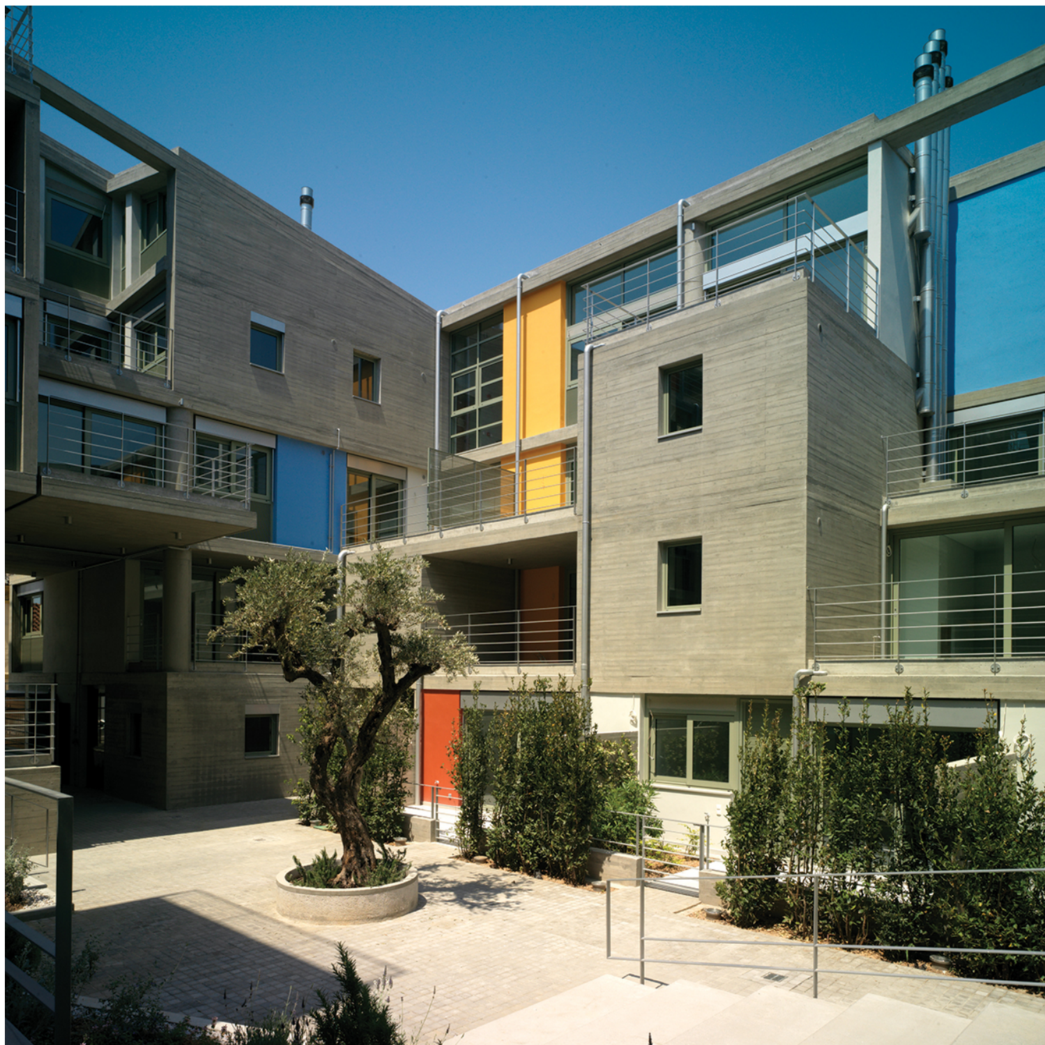
Εσωτερική όψη από το αίθριο
