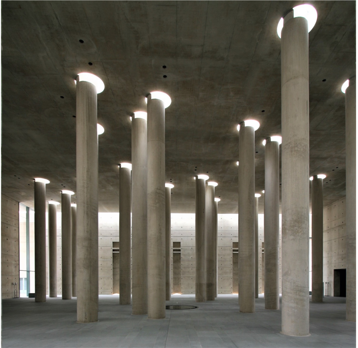
Axel Schultes, Charlotte Frank, Κρεματόριο στο Τρέπτοβ (Βερολίνο), 1999 (φωτογρ. Α. Γιακουμακάτος)
