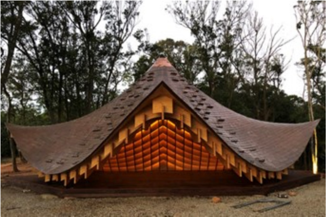
Εικόνα 15: Tao Temple, Taiwan 2018, FUNYA FUNYA, Courtesy Kengo Kuma & Associates
