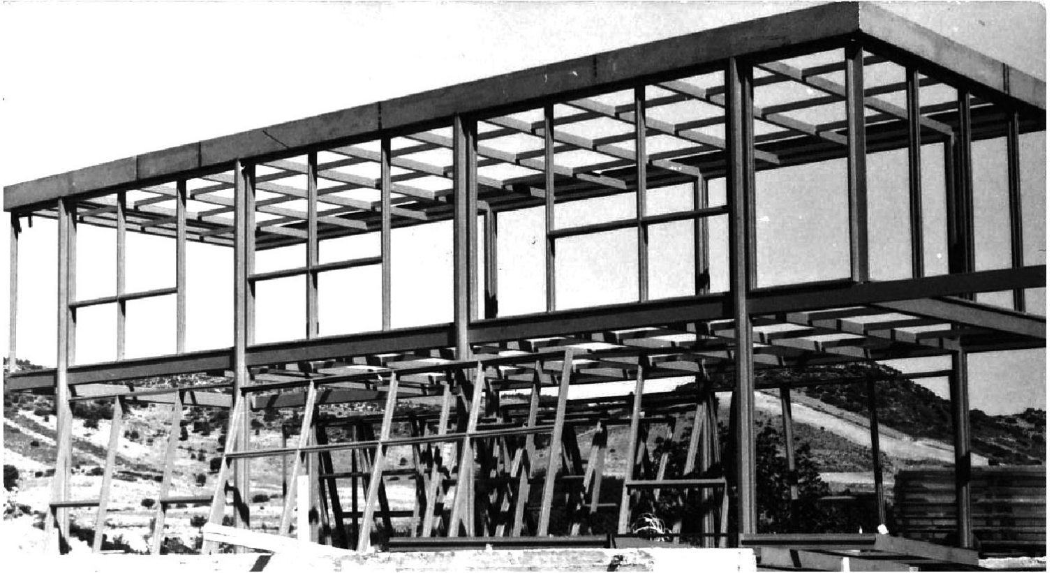
Εικ. 2. Λαγονήσι, 1977: Κατά τη διάρκεια κατασκευής: Ο μεταλλικός σκελετός της κατοικίας I (αρχείο Μανώλη Γλυνιαδάκη)
