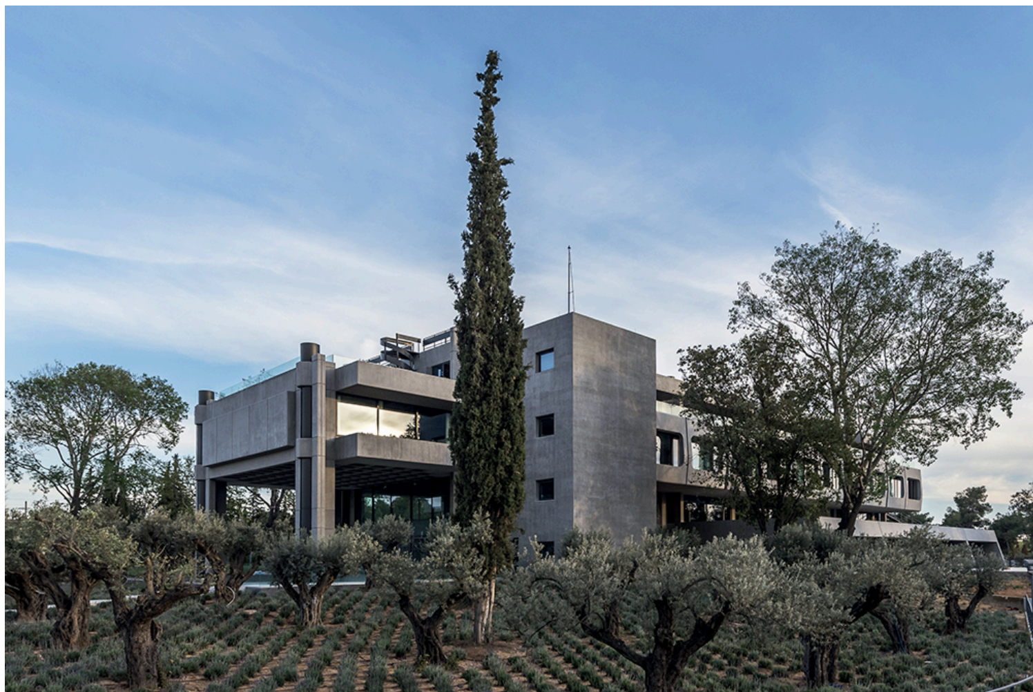
Γιώργος Μπάτζιος, Κτίριο γραφείων στη Λυκόβρυση (πρώην ΑΓΕΤ ΗΡΑΚΛΗΣ: Αλέξανδρος Τομπάζης, 1972), 2018-2020.
