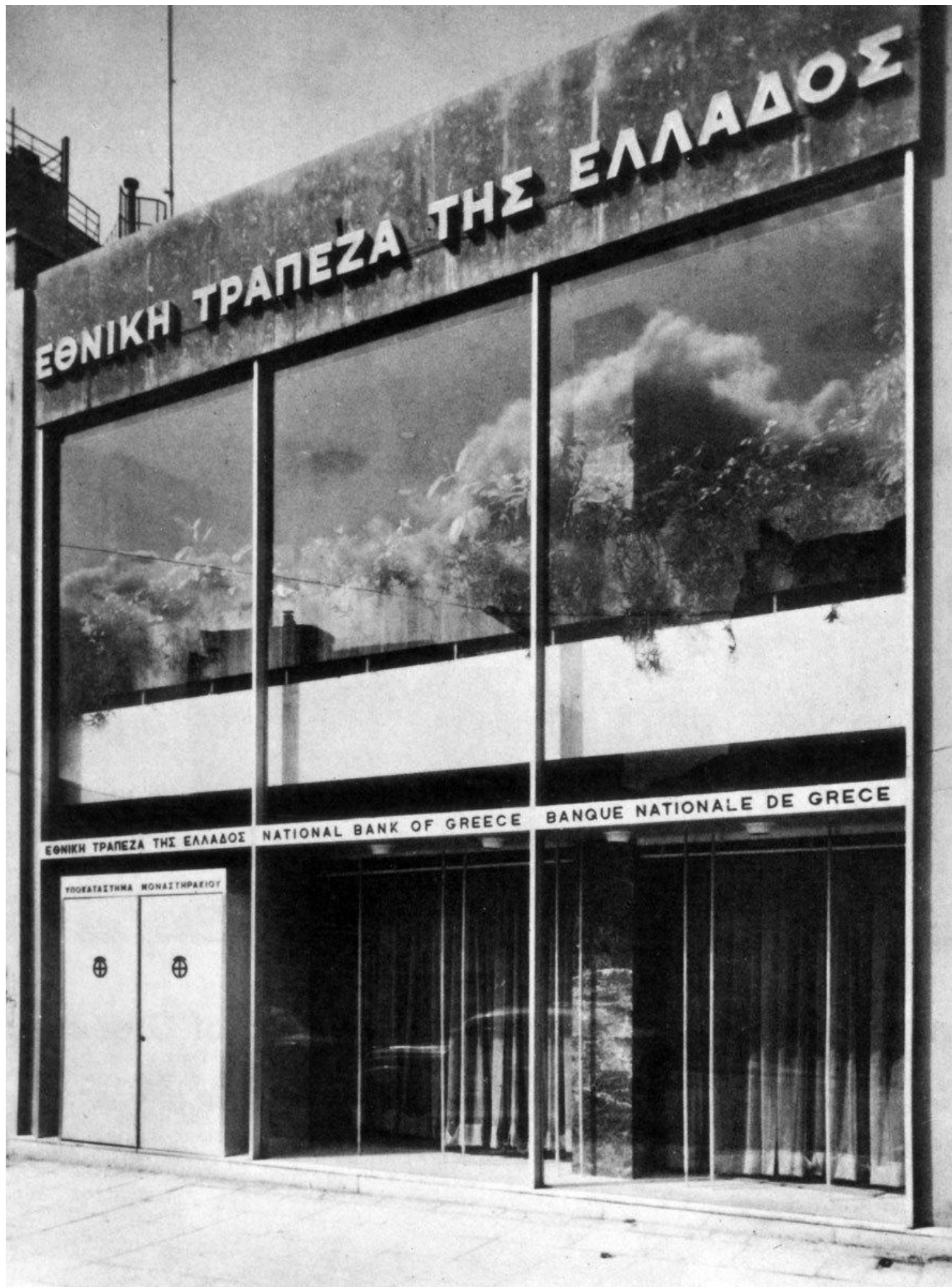
Υποκατάστημα Ε.Τ.Ε. στο Μοναστηράκι, Κ. Δεκαβάλλας 1961
