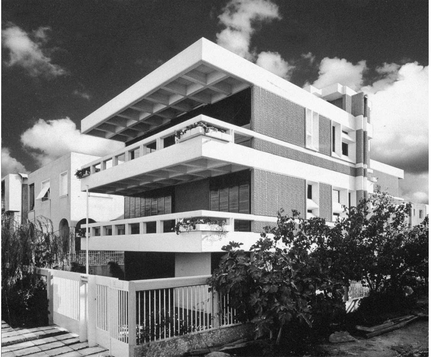
Β. Μπογάκος, Πολυκατοικία οδού Τζαβέλλα 4 στο Νέο Ψυχικό, 1968.
