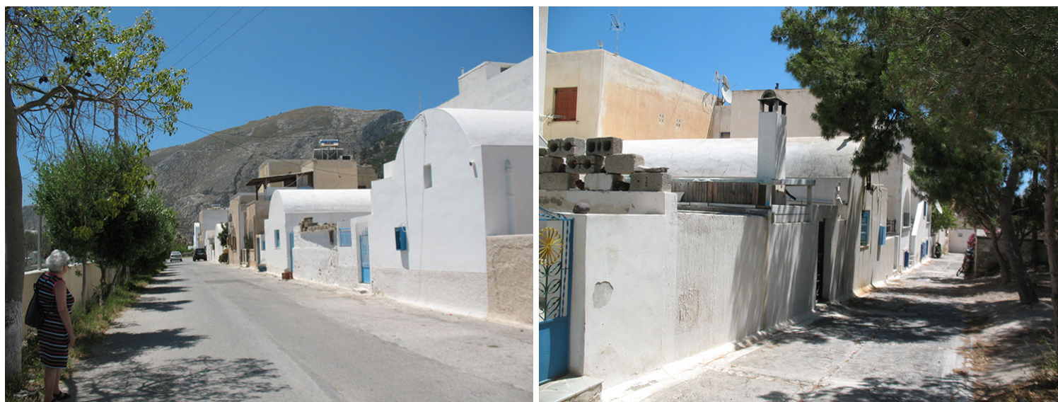
Παλιοί θόλοι επισκευασμένοι, και άλλοι με προσθήκη ορόφου
