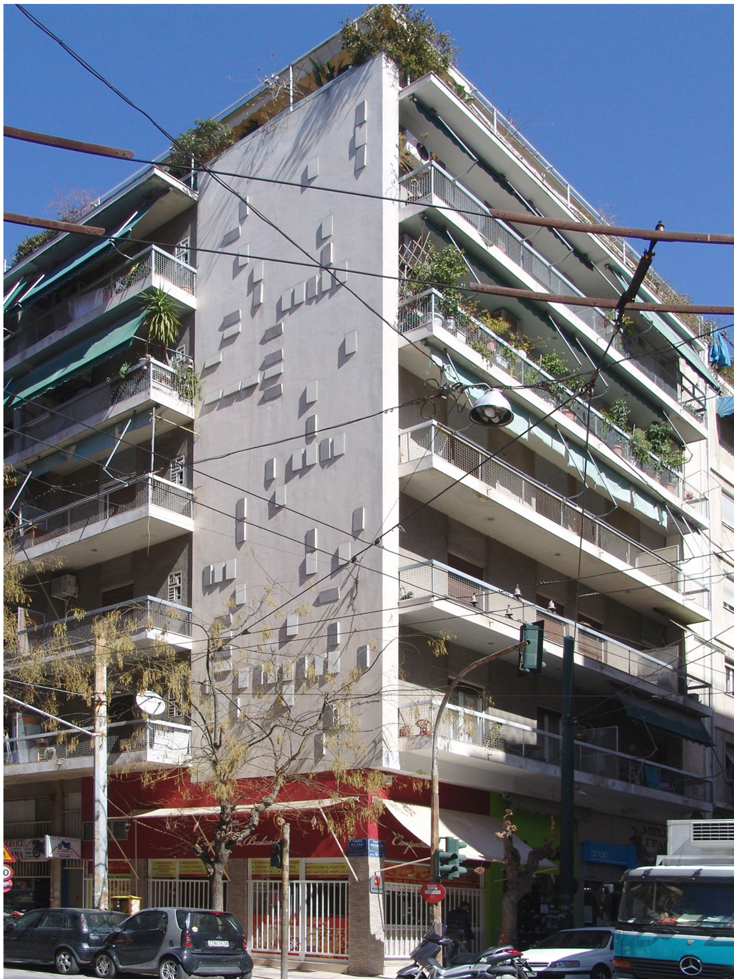
Εικ. 7 Γενική άποψη κτιρίου (φωτ. Ε. Αμερικόπουλου, Μάρτιος 2013).
