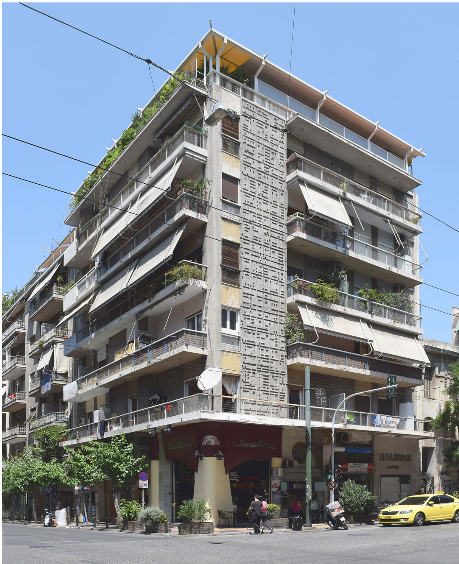
Εικ. 3 Γενική άποψη κτιρίου (φωτ. Π. Εξαρχόπουλος, Ιούνιος 2017).
