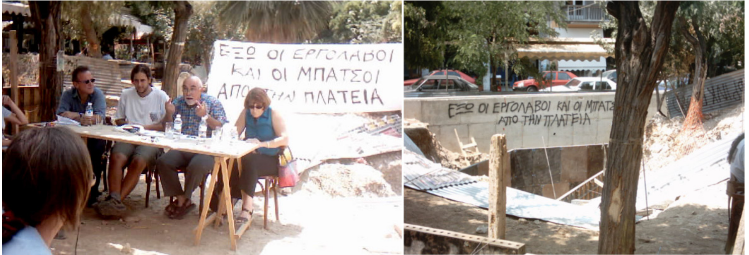
Εικόνα 1. Συνέντευξη τύπου. Διακρίνεται δεξιά η Ελένη Πορτάλιου. (Φωτογραφίες 1, 2, 3: Δ. Σιατίτσα) Εικόνα 2. Η πλατεία - εργοτάξιο.
