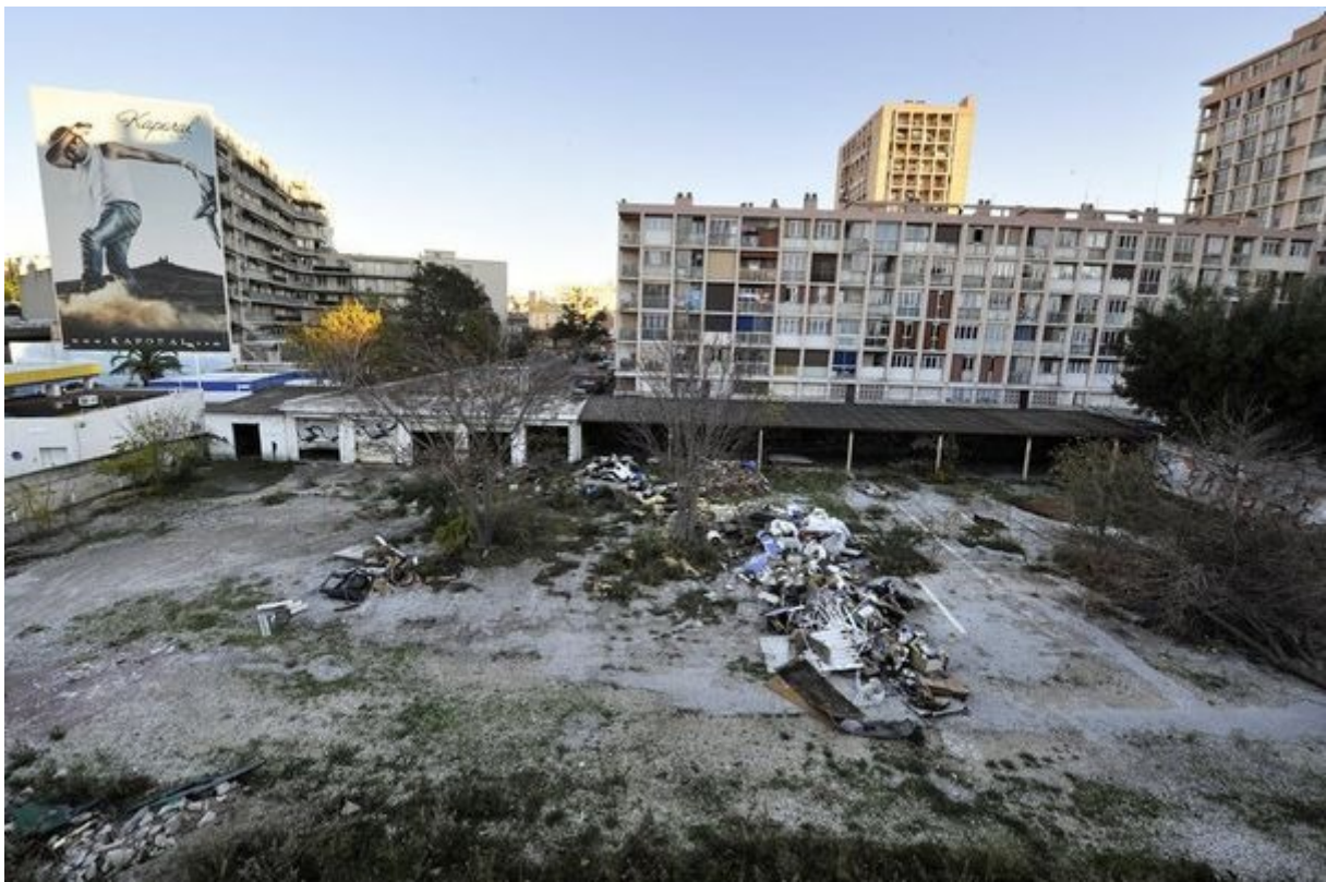
39. HLM πανάθλιες κατοικίες, «αποθήκες εργατικών χεριών» (HLM, Habitation à Loyer Modéré, η χαμηλού κόστους κατοικία οργανωμένης δόμησης στην Γαλλία μετά τον Πόλεμο). (πηγή, διαδίκτυο, HLM, 684918_vue-generale-d-un-quartier-de-marseille.jpg )
