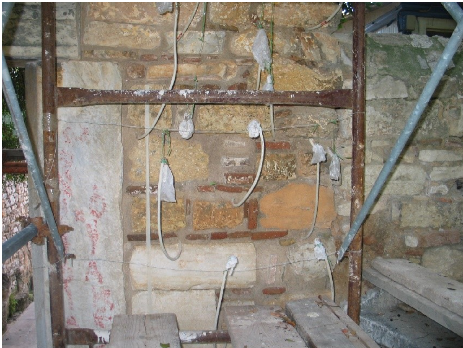
Εφαρμογή ενεμάτων σε τοιχοποιίες. Οι σωληνίσκοι πρέπει να τοποθετούνται με το άνω άκρο προς τα πάνω. Πηγή Εικόνων: Α. Μιλτιάδου
