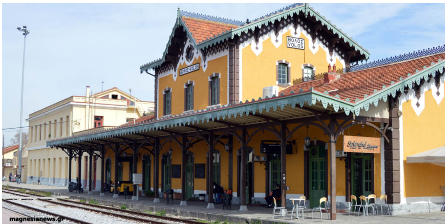
12. Σιδηροδρομικός σταθμός Βόλου
