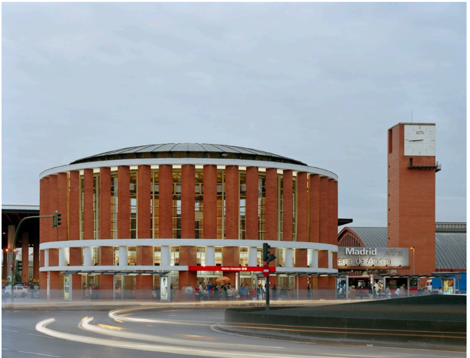
8. Madrid Atocha Station, Βορειοανατολική όψη του σταθμού
