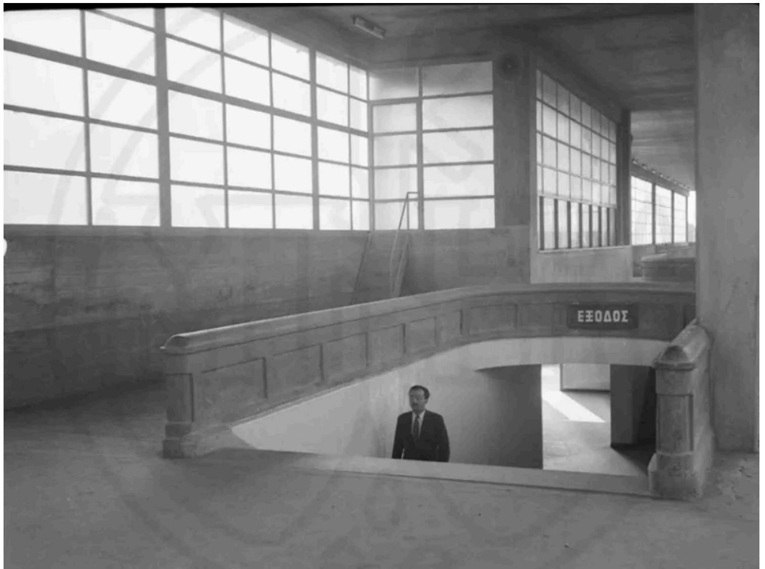
10. Νέος Σιδηροδρομικός σταθμός Θεσσαλονίκης (ΝΕΣΘ) (πρώτης κατηγορίας), Εσωτερική διαμόρφωση υπόγειου διαδρόμου που καταλήγει στις αποβάθρες του σταθμού
