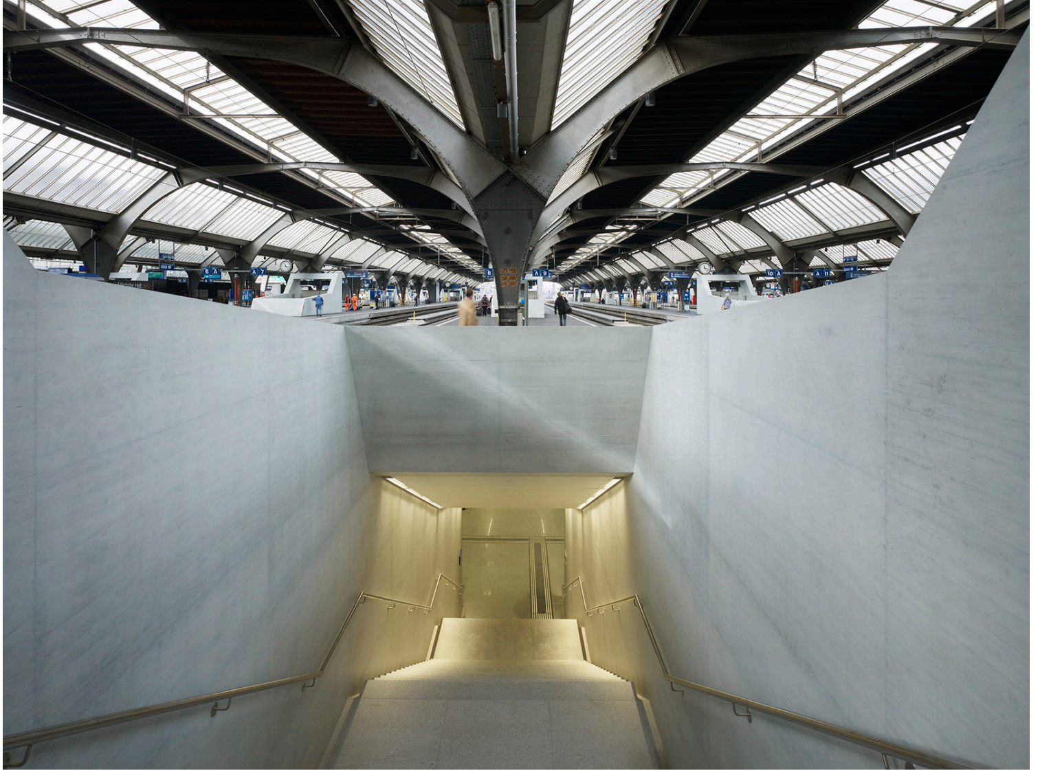
6. Zurich Central Station, Πέρασμα προς το υπόγειο τμήμα του μετρό
