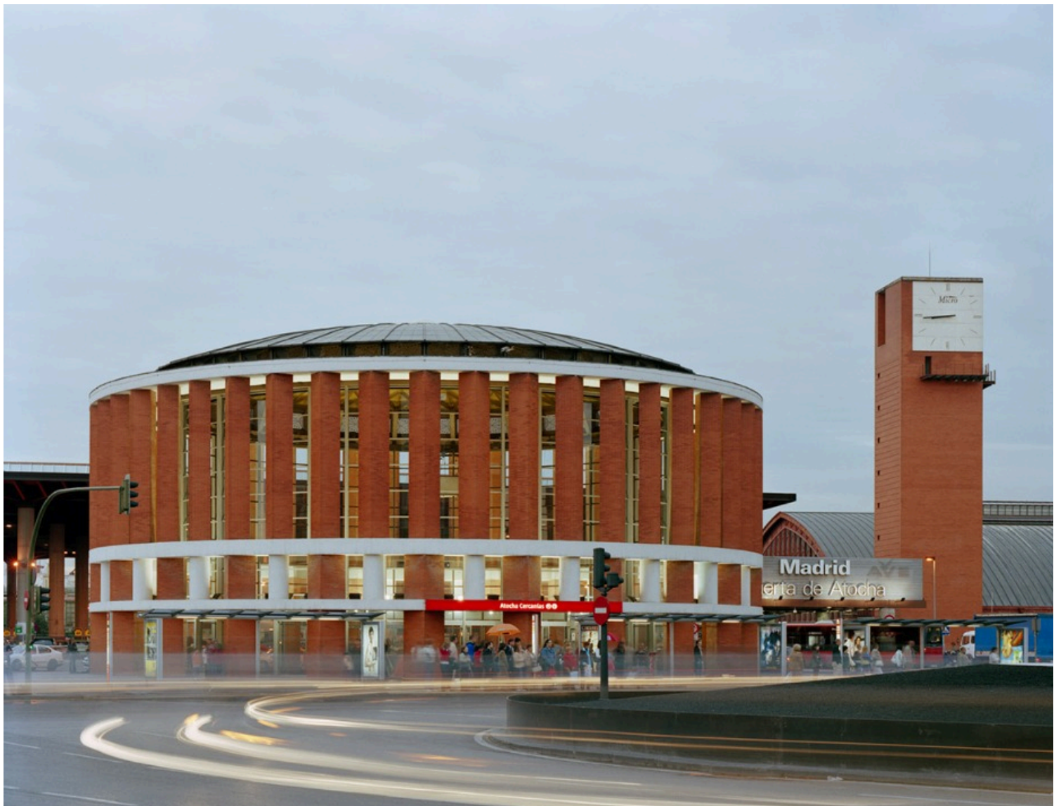
8. Madrid Atocha Station, Βορειοανατολική όψη του σταθμού
