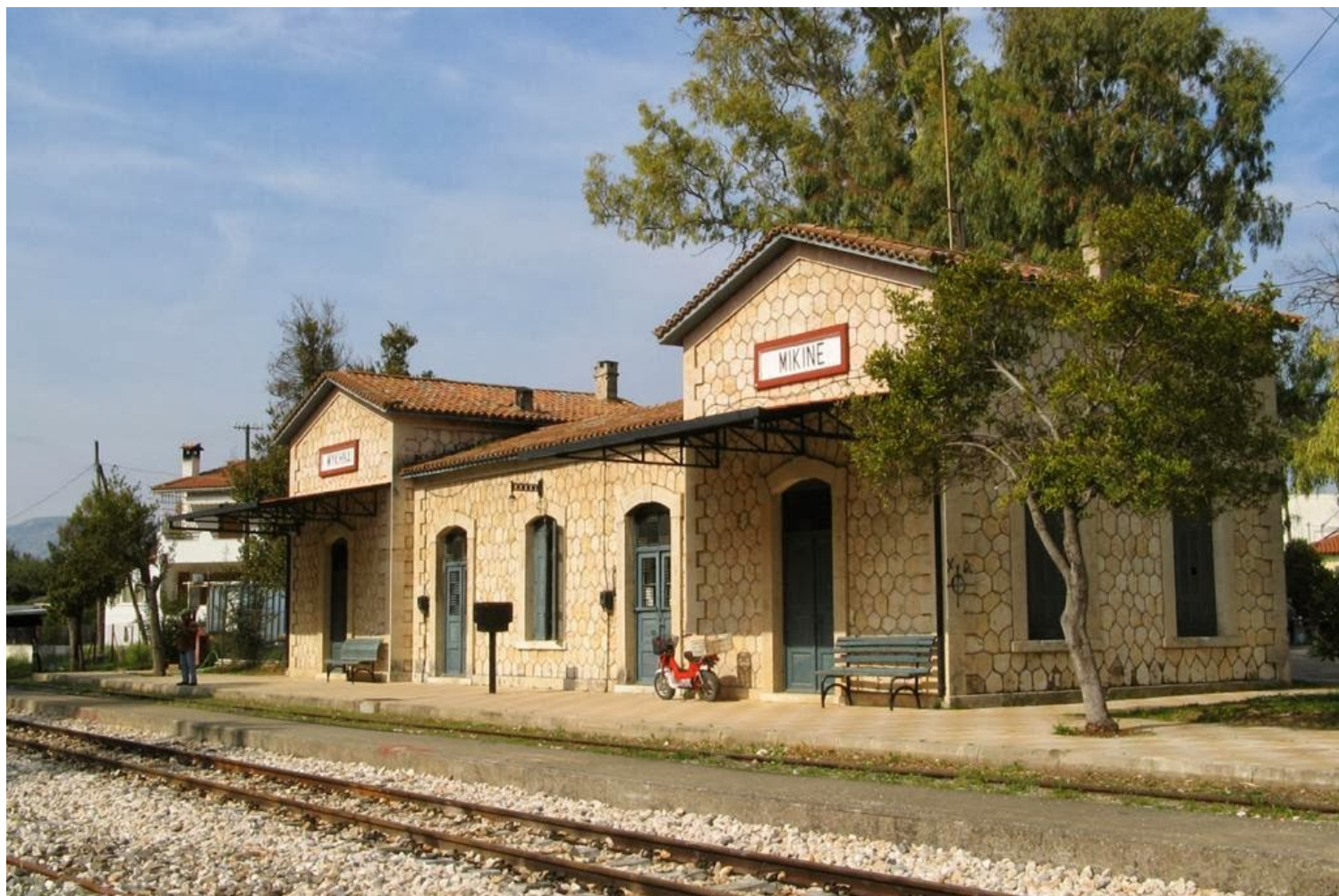
2. Σιδηροδρομικός σταθμός Μυκητών, Όψη σταθμού από την πλευρά των αποβαθρών
