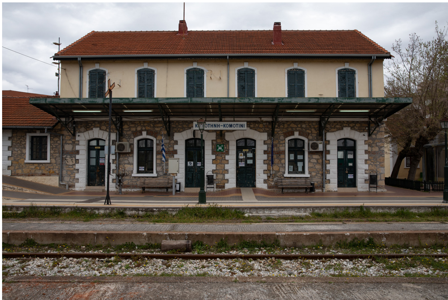
11. Σιδηροδρομικός σταθμός Κομοτηνής, Όψη από την πλευρά των αποβαθρών
