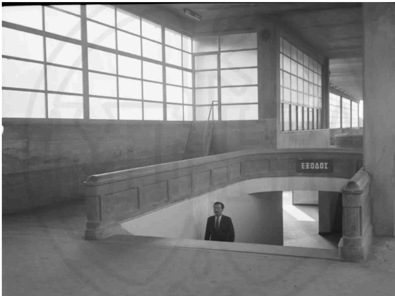
10. Νέος Σιδηροδρομικός σταθμός Θεσσαλονίκης (ΝΕΣΘ) (πρώτης κατηγορίας), Εσωτερική διαμόρφωση υπόγειου διαδρόμου που καταλήγει στις αποβάθρες του σταθμού
