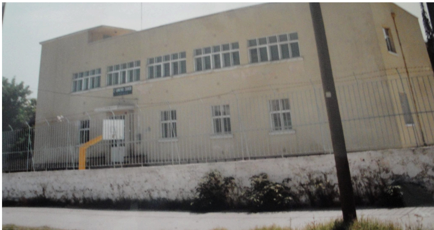
Εικόνα 7. Η βόρεια όψη του Δεύτερου Δημοτικού Σχολείου της Ξάνθης (Καραντινός) πριν την προσθήκη πτέρυγας. Τα ανοίγματα εμφανίζονται τροποποιημένα και απουσιάζει το στέγαστρο. Πηγή εικόνας: «Παλιές φωτογραφίες της Ξάνθης», δημόσια ομάδα στο facebook (ανάρτηση Antonis Kalogiannidis, 13-10-2017), πρόσβαση Ιανουάριος 21, 2021, https://www.facebook.com/groups/237817546256513/ .
