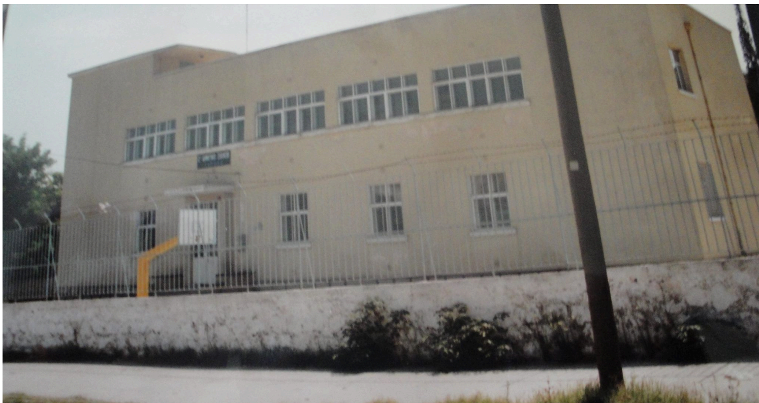
Εικόνα 7. Η βόρεια όψη του Δεύτερου Δημοτικού Σχολείου της Ξάνθης (Καραντινός) πριν την προσθήκη πτέρυγας. Τα ανοίγματα εμφανίζονται τροποποιημένα και απουσιάζει το στέγαστρο. Πηγή εικόνας: «Παλιές φωτογραφίες της Ξάνθης», δημόσια ομάδα στο facebook (ανάρτηση Antonis Kalogiannidis, 13-10-2017), πρόσβαση Ιανουάριος 21, 2021, https://www.facebook.com/groups/237817546256513/ .
