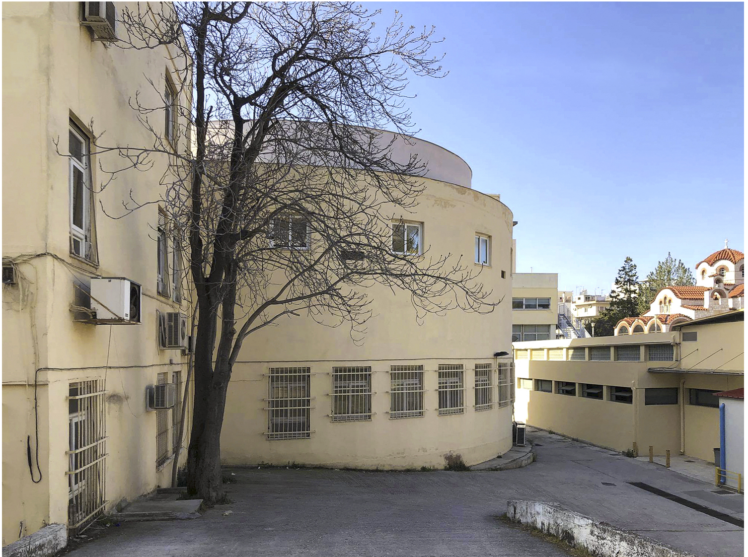
Εικ. 6. Το ημικυκλικό Αμφιθέατρο του Ανατομικού Ινστιτούτου. Πρόσφατη εξωτερική άποψη. [Πηγή: φωτ. Σπύρος Σγούρος, Απρίλιος 2021]
