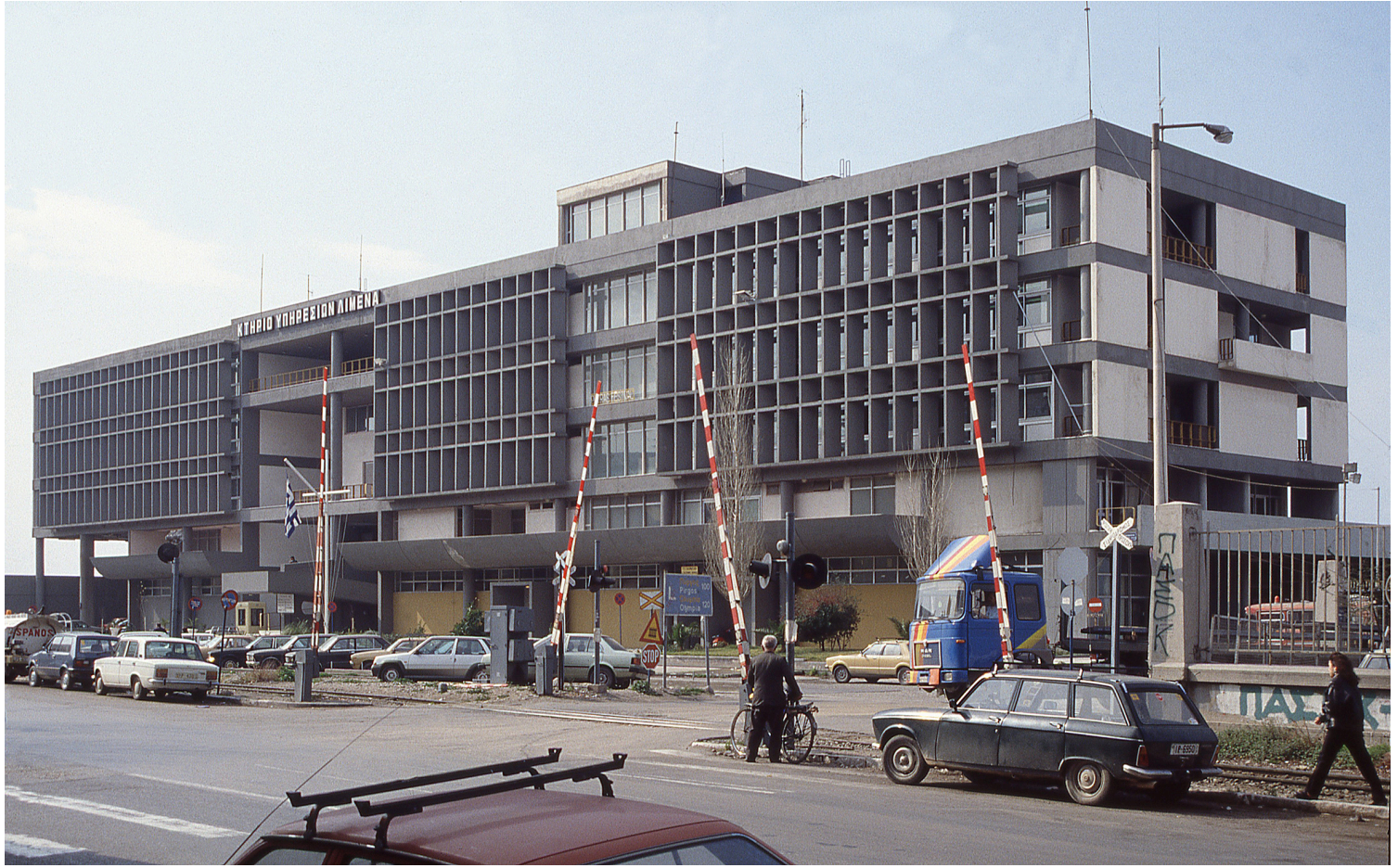
Εικ. 12. Κτίριο Υπηρεσιών Οργανισμού Λιμένα Πατρών. Γενική άποψη. [Πηγή: φωτ. Πάνος Εξαρχόπουλος, 1990]
