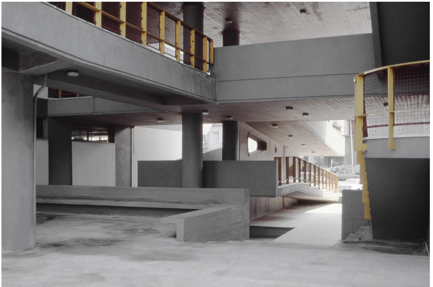
Εικ. 15. Ο διαμπερής, διπλού ύψους, ημιυπαίθριος χώρος εισόδου, με ελεύθερη ραμπόσκαλα και κλιμακοστάσιο. Ένα πραγματικό μάθημα αρχιτεκτονικής. [Πηγή: φωτ. Πάνος Εξαρχόπουλος, 1990]
