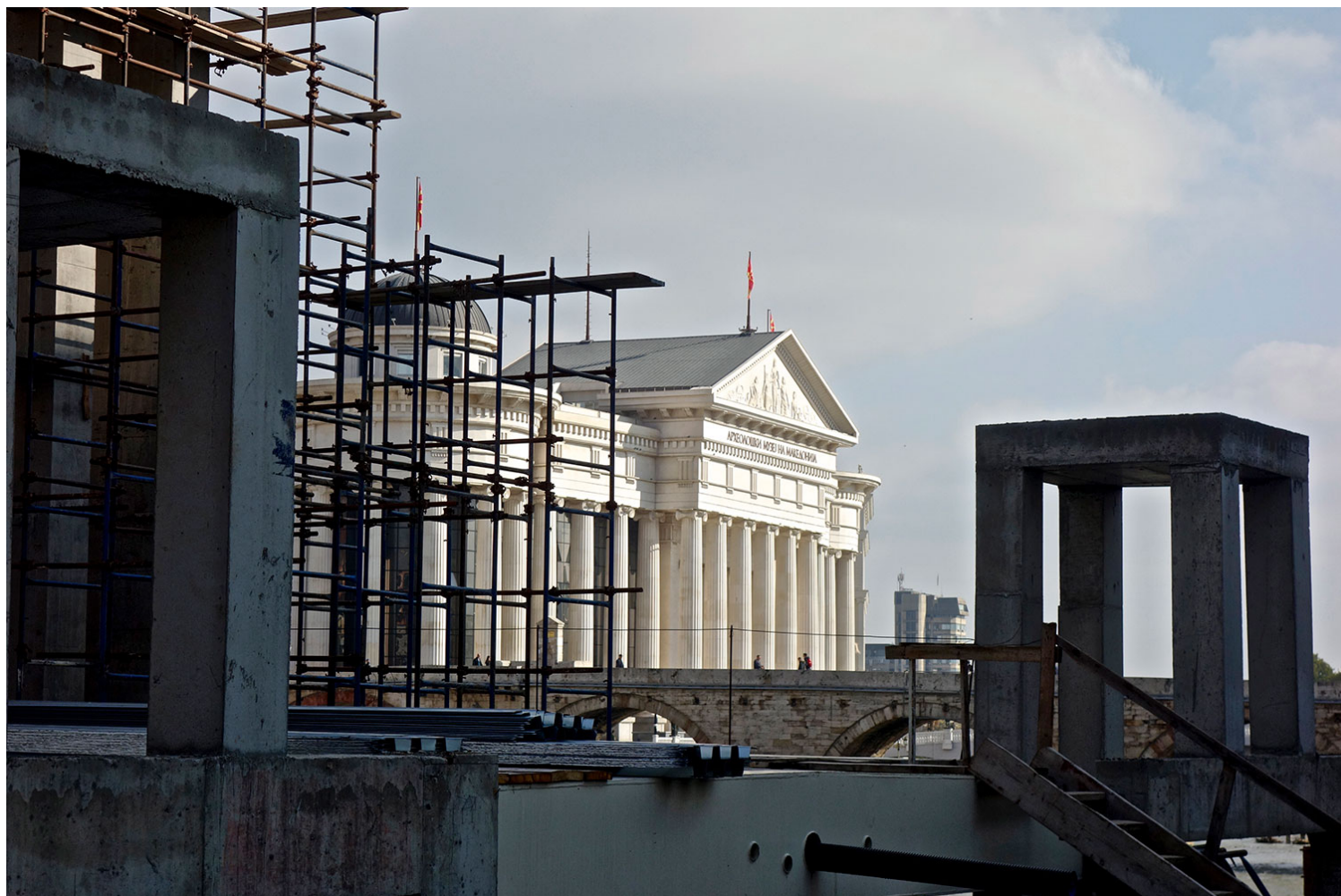
Εικ.2. Άποψη του αρχαιολογικού μουσείου μέσα από το εργοτάξιο της ρόδας θέασης πάνω στο ποτάμι. Φωτογραφία: Καλλιόπη Αμυγδάλου, 2017.
