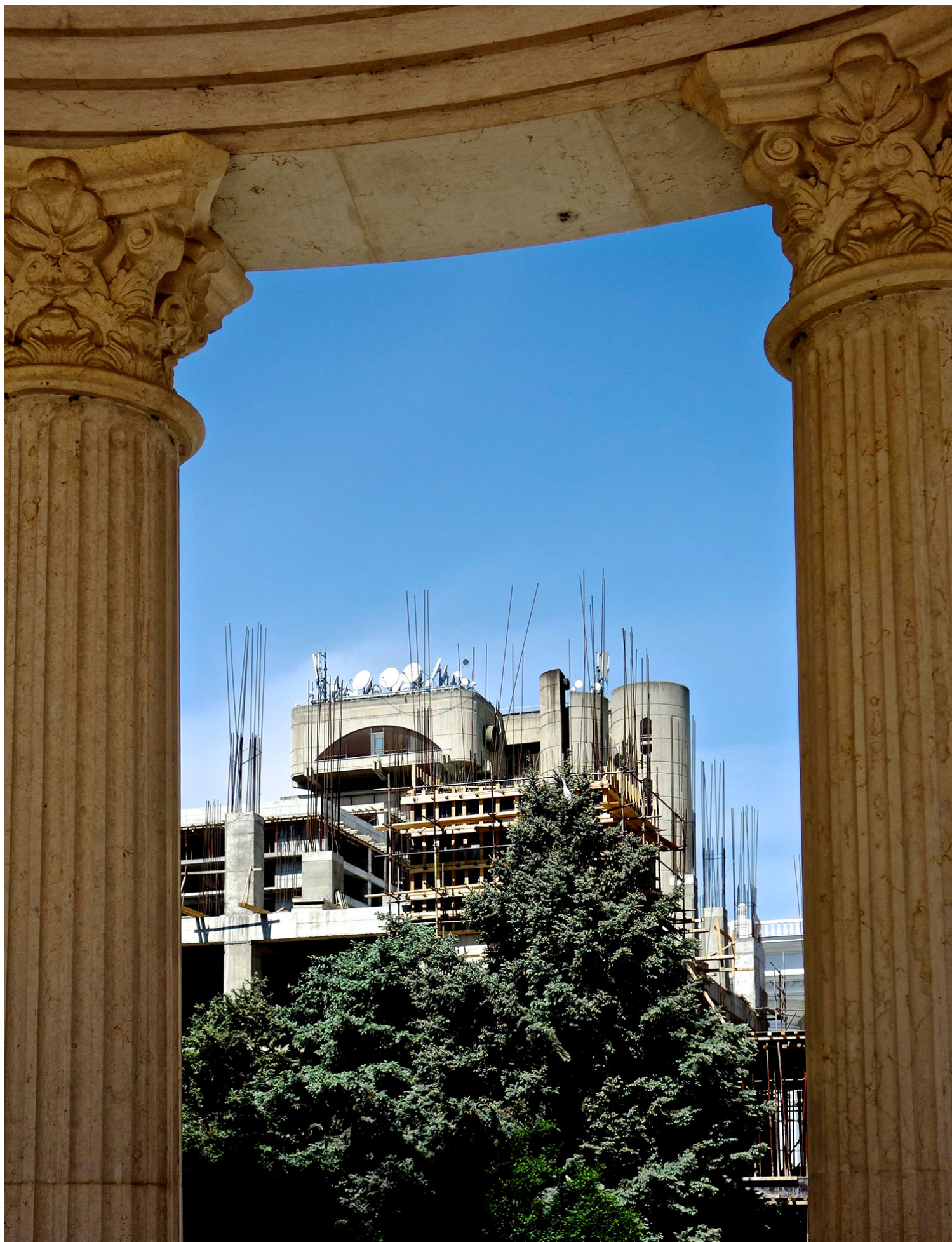
Εικ. 5. Το Κτήριο Τηλεπικοινωνιών (1968–81. Janko Konstantinov), όπως φαίνεται μέσα από τις κολώνες ενός περιπτέρου στην κεντρική πλατεία της πόλης. Φωτογραφία: Καλλιόπη Αμυγδάλου, 2017.
