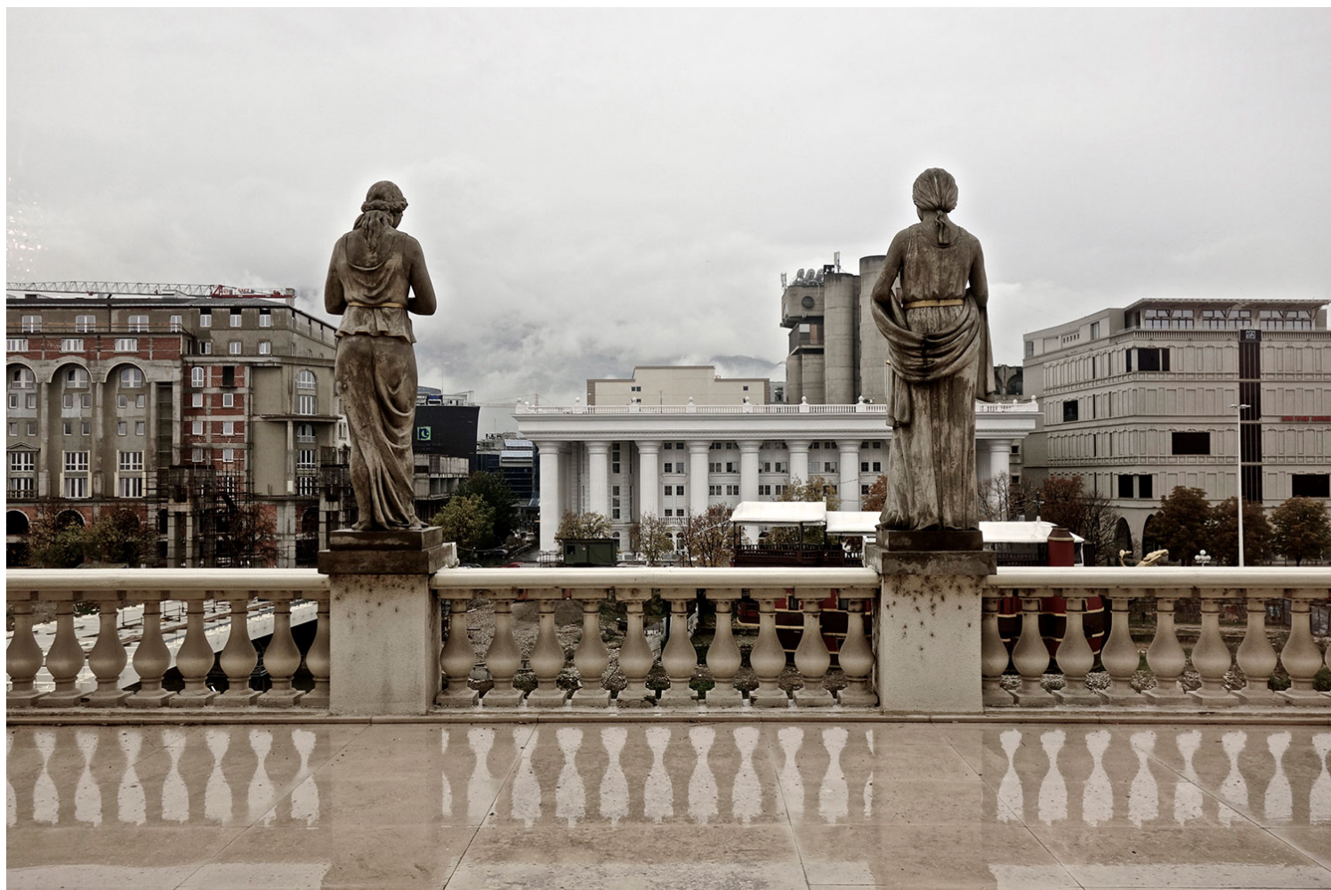
Εικ.4. Το νέο παραποτάμιο μέτωπο, όπως φαίνεται από την ταράτσα του ανακατασκευασμένου Εθνικού Θεάτρου. Αριστερά είναι η ρέπλικα της Λέσχης Αξιωματικών, στο κέντρο το κτήριο του Εθνικού Διανομέα Ηλεκτρικής Ενέργειας (ΜΕΡΨΟ) πλέον 'ντυμένο' με κλασική όψη, και δεξιά ένα νέο κτήριο στάθμευσης αυτοκινήτων σε 'μπάρók' ρυθμό. Φωτογραφία: Καλλιόπη Αμυγδάλου, 2017.
