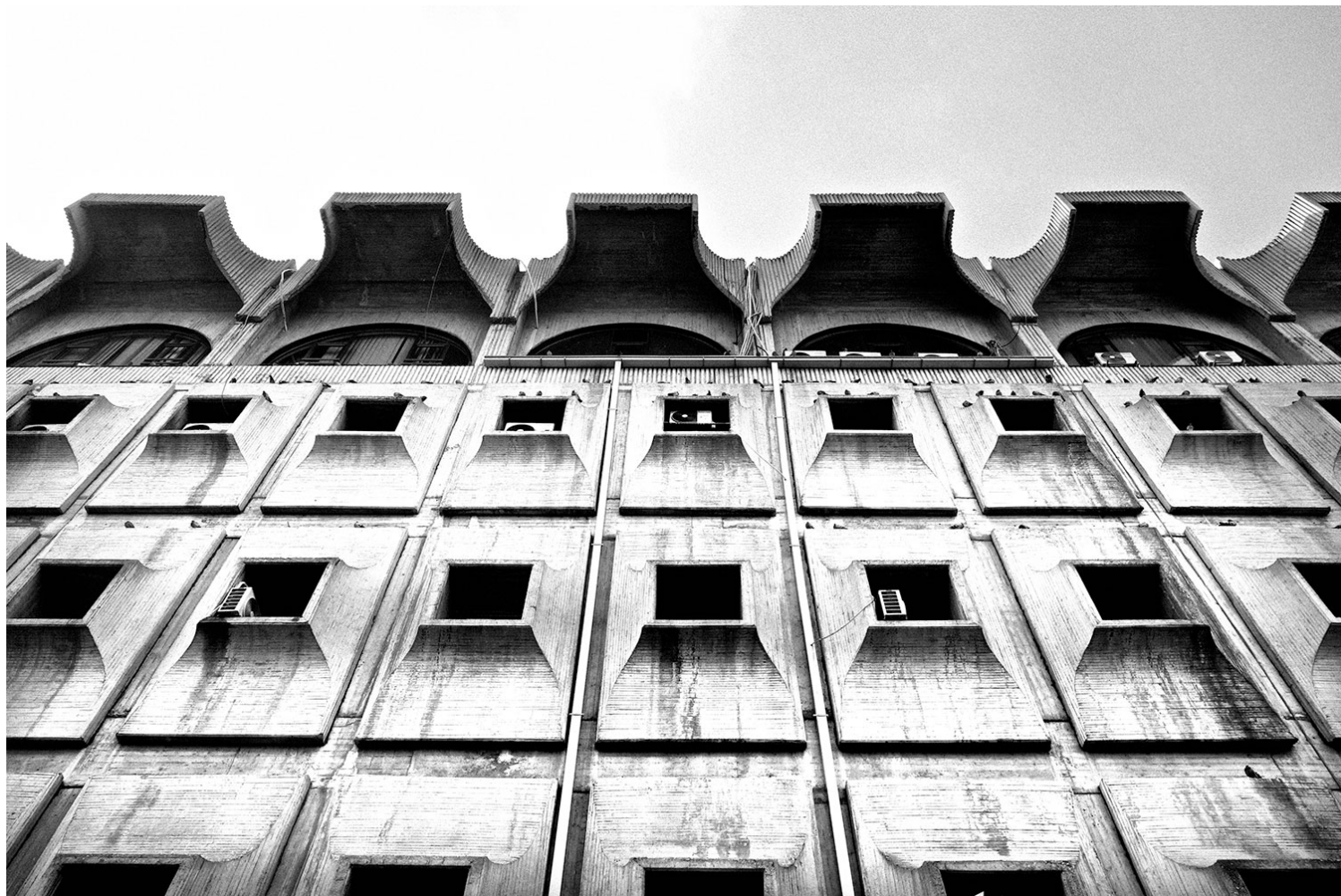
Εικ. 1. Όψη του Κτηρίου Τηλεπικοινωνιών, 1968-81. Janko Konstantinov (1926-2010). Φωτογραφία: Καλλιόπη Αμυγδάλου, 2017.
