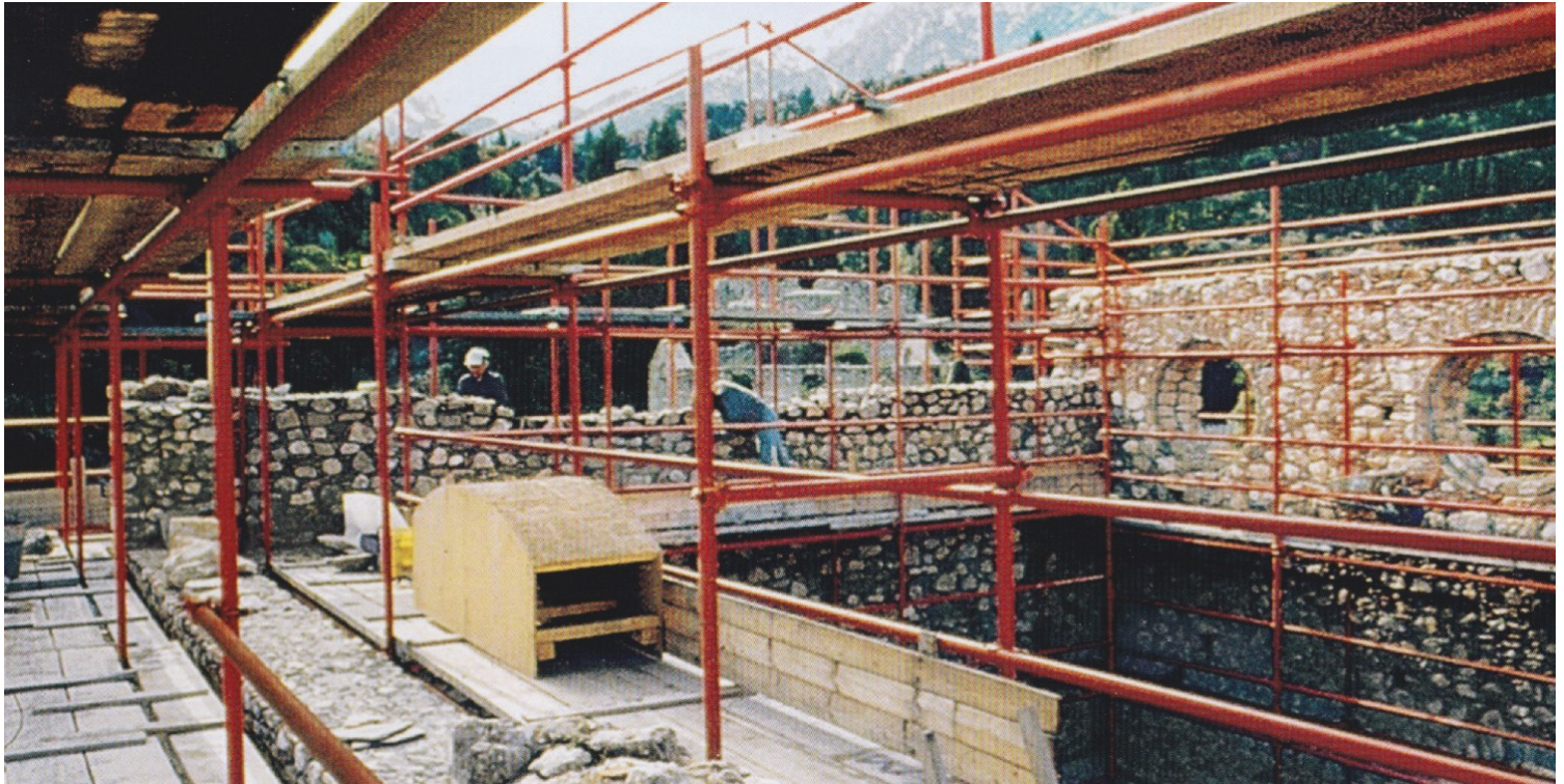
Ανακατασκευή του δυτ. τοίχου της Αίθουσας του Θρόνου
