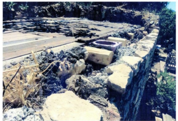
ΚΑΛΟΥΠΩΜΑ ΠΛΑΚΑΣ ΟΡΟΦΗΣ ΣΤΟ ΦΟΥΡΝΟΣΠΙΤΟ-ΤΟΠΟΘΕΤΗΣΗ ΠΡΟΚΑΤΑΣΚΕΥΑΣΜΕΝΩΝ ΣΤΟΙΧΕΙΩΝ ΔΙΑΜΟΡΦΩΣΗΣ ΚΑΜΙΝΑΔΑΣ
