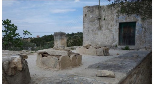
ΦΩΤΙΣΤΙΚΑ ΑΝΟΙΓΜΑΤΑ ΚΑΙ ΠΛΑΚΑ ΜΠΕΤΟΝ ΣΤΟ ΔΩΜΑ ΤΟΥ ΠΑΡΑΣΠΙΤΟΥ
