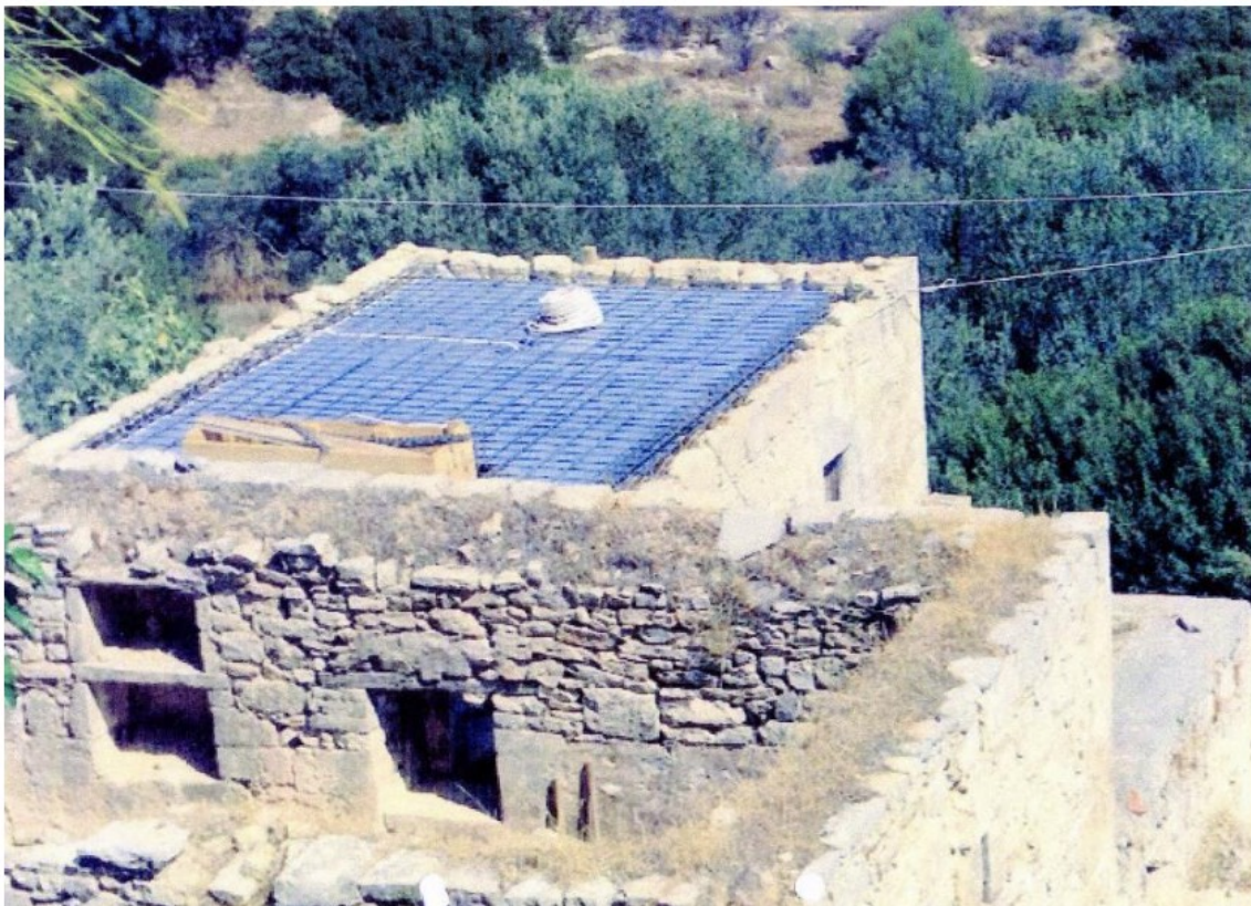
ΕΡΓΑΣΙΕΣ ΚΑΛΟΥΠΟΥΜΑΤΟΣ ΚΑΙ ΟΠΛΙΣΜΟΥ ΠΛΑΚΑΣ ΟΡΟΦΗΣ ΚΥΡΙΩΣ ΟΙΚΙΑΣ
