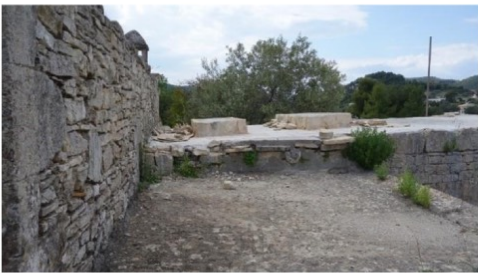
ΦΩΤΙΣΤΙΚΑ ΑΝΟΙΓΜΑΤΑ (SKYLIGHTS) ΣΤΟ ΔΩΜΑ ΤΗΣ ΚΥΡΙΑΣ ΚΑΤΟΙΚΙΑΣ
