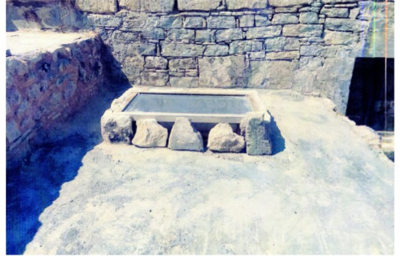
ΦΩΤΙΣΤΙΚΟ ΑΝΟΙΓΜΑ ΚΑΙ ΠΛΑΚΑ ΜΠΕΤΟΝ ΣΤΟ ΔΩΜΑ ΤΟΥ ΣΤΑΒΛΟΥ
