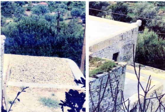
ΔΙΑΜΟΡΦΩΣΗ ΔΩΜΑΤΩΝ ΤΗΣ ΒΟΡΕΙΟΑΝΑΤΟΛΙΚΗΣ ΠΛΕΥΡΑΣ
