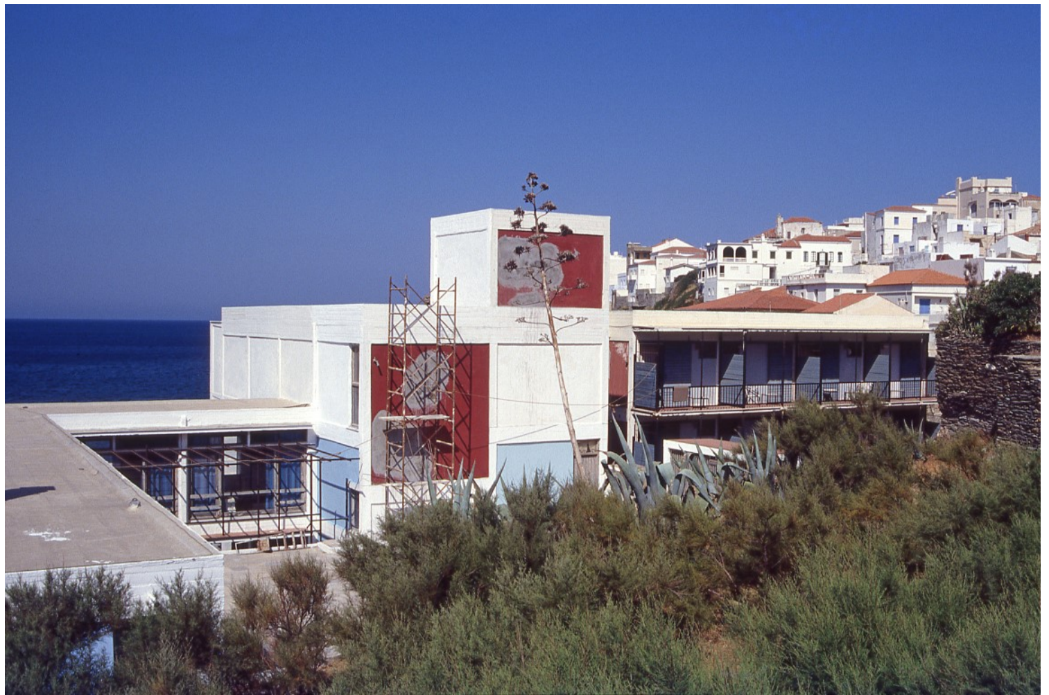
Η νότια όψη. Διακρίνεται η μικρή εσωτερική αυλή και ο «πύργος» του κλιμακοστασίου
